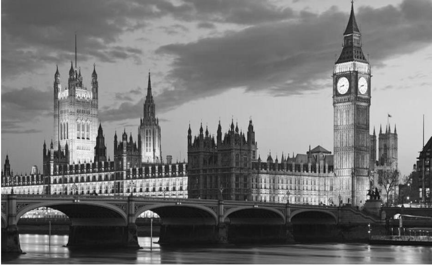
(α). Το κτίριο του Κοινοβουλίου της Αγγλίας, στο Λονδίνο.
